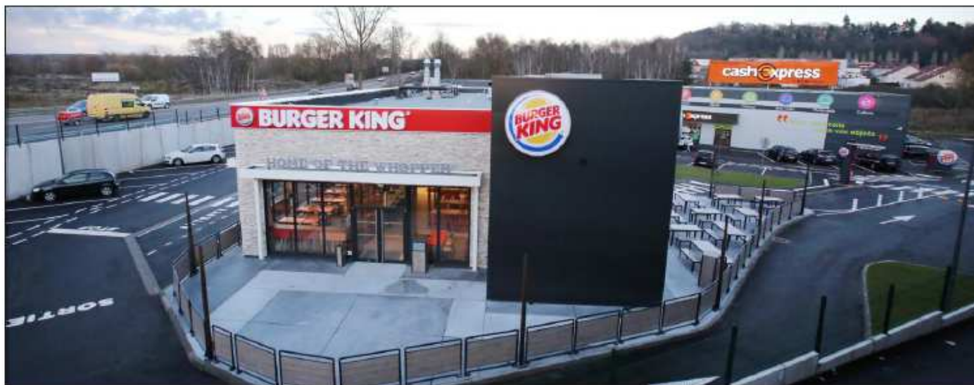
Burger king, Cash express et Ozéo cuisines sont les trois nouveaux magasins qui se dressent à la place de l'ancien garage Ford. Photo Thierry Sanchez
